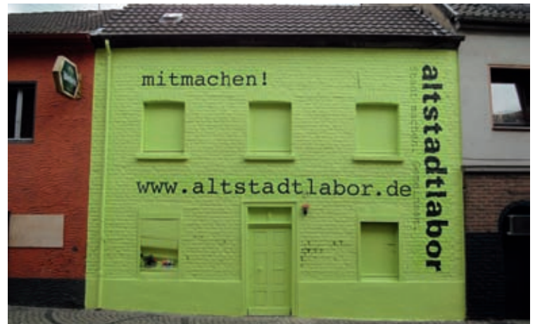
Die Fassade eines leerstehenden Gebäudes in der Altstadt dient als Werbefläche in eigener Sache.
