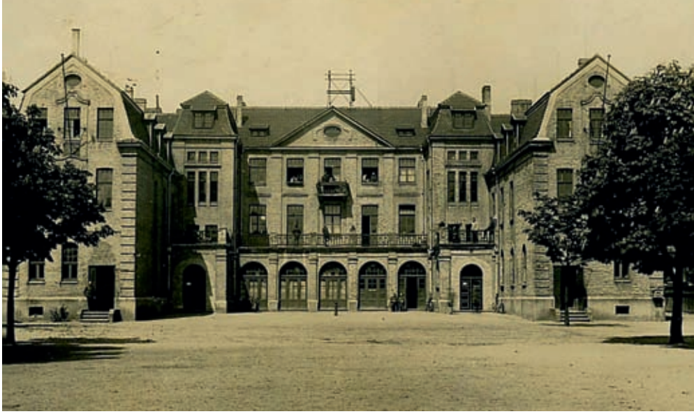
Das ehemalige Ledigenheim als Standort der 1. Polizeibereitschaft vor 1930.
